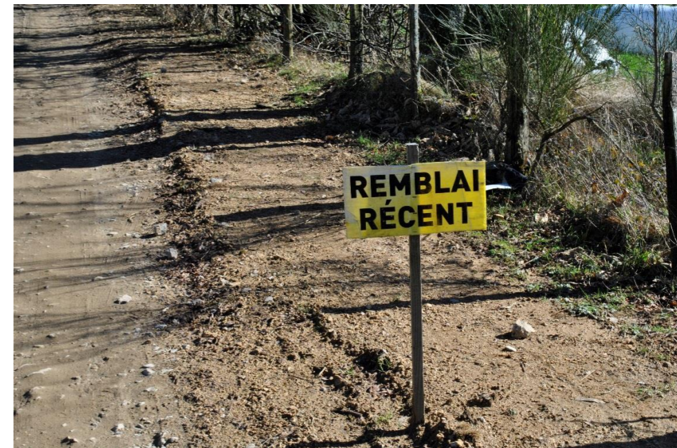
Photographie 27 : Exemple de remblai des tranchées électriques le long d'une piste
