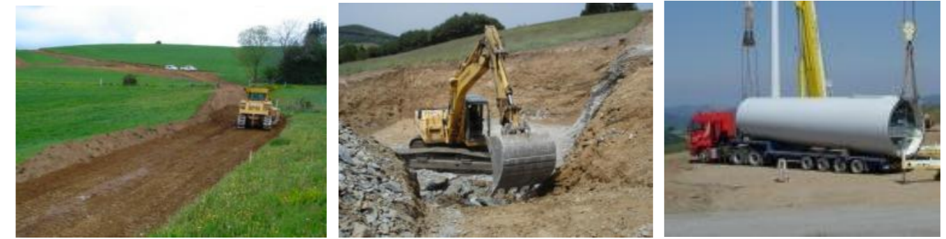
Photographie 29 : Illustration d'un chantier éolien
