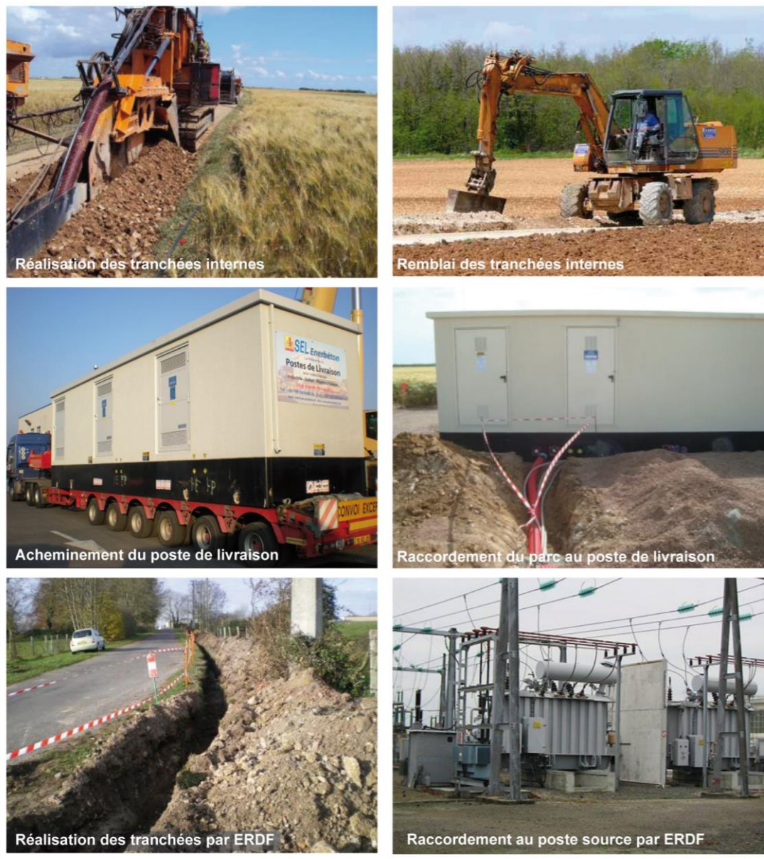
Photographie 22 : Travaux de raccordement électrique
