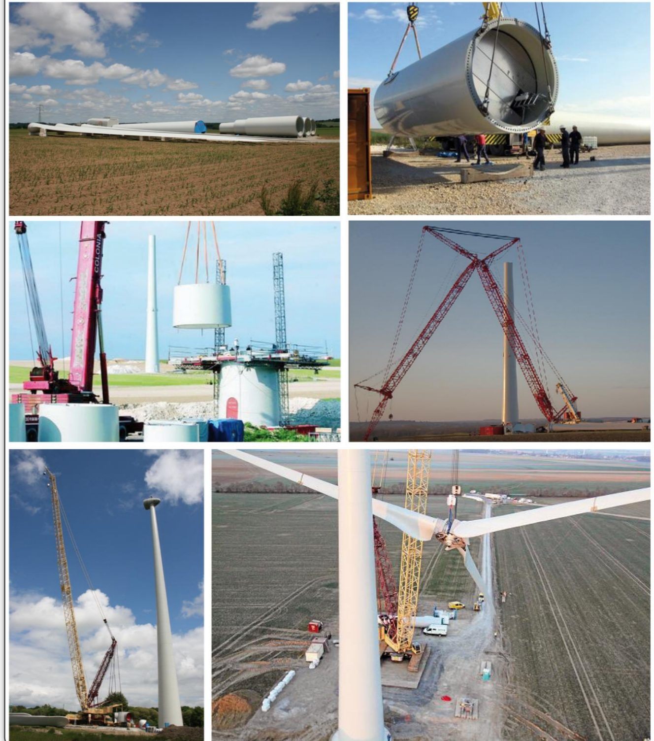
Montage d'une éolienne
