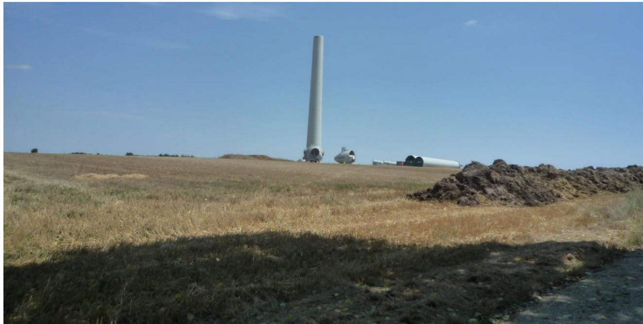
Photographie 26 : Exemple de stockage de terre durant un chantier éolien
